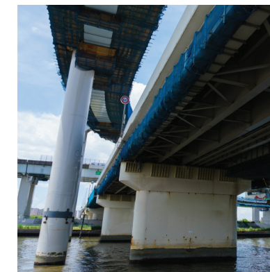
piles de pont
